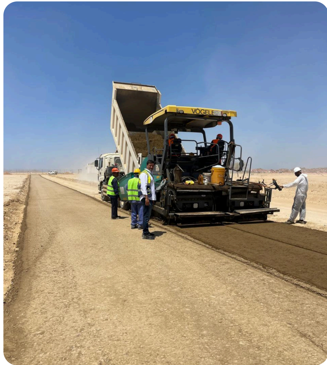
أعمال الحفر وردم الطرق وتوريد المواد
