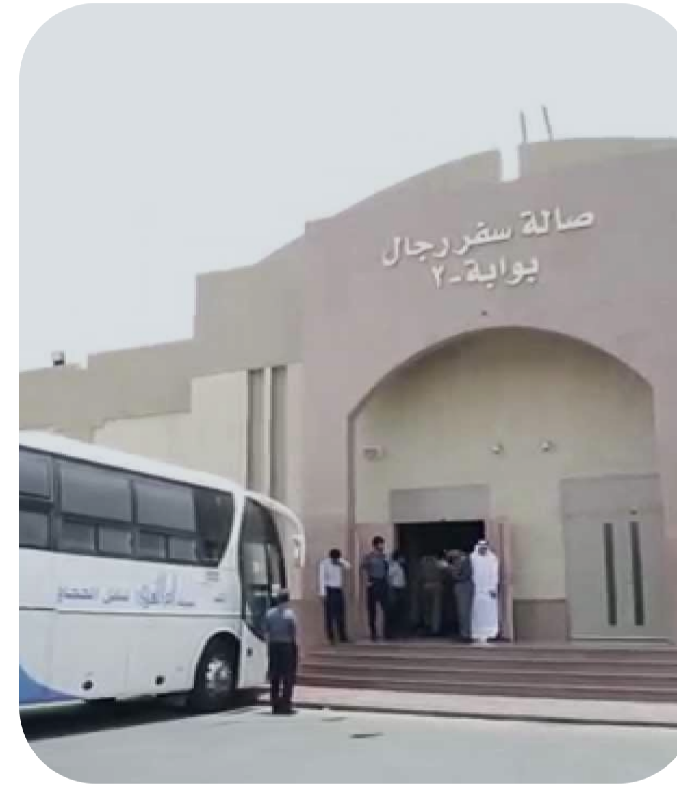
مشروع مركز الايواء (السجون) - الشميسي
