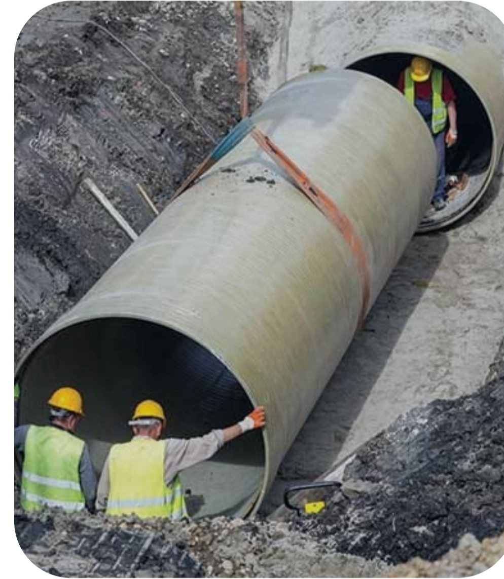
مشروع الصرف الصحي مع بلدية المدينة المنورة - المدينة المنورة
