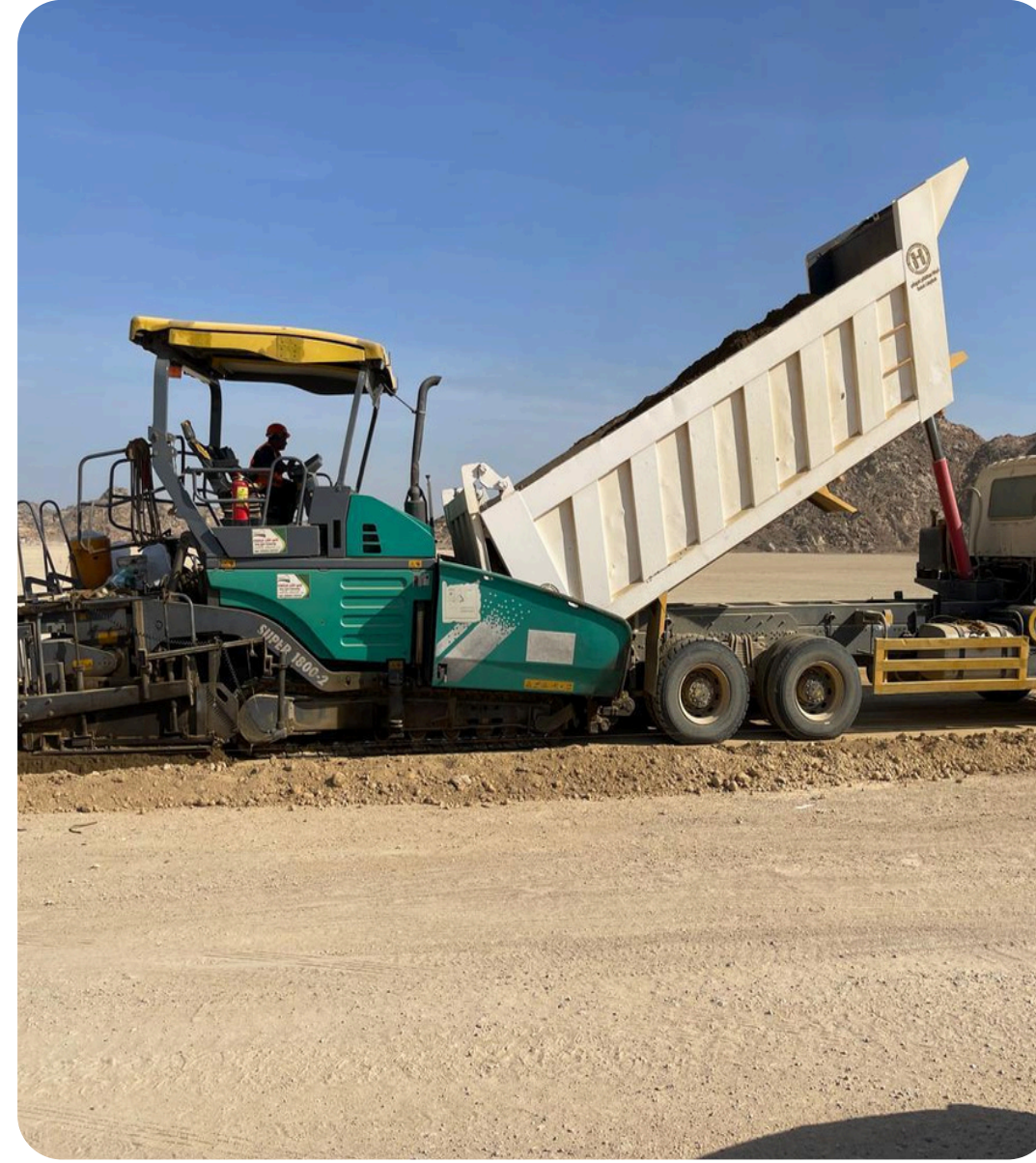
أعمال الحفر وردم الطرق وتوريد المواد
