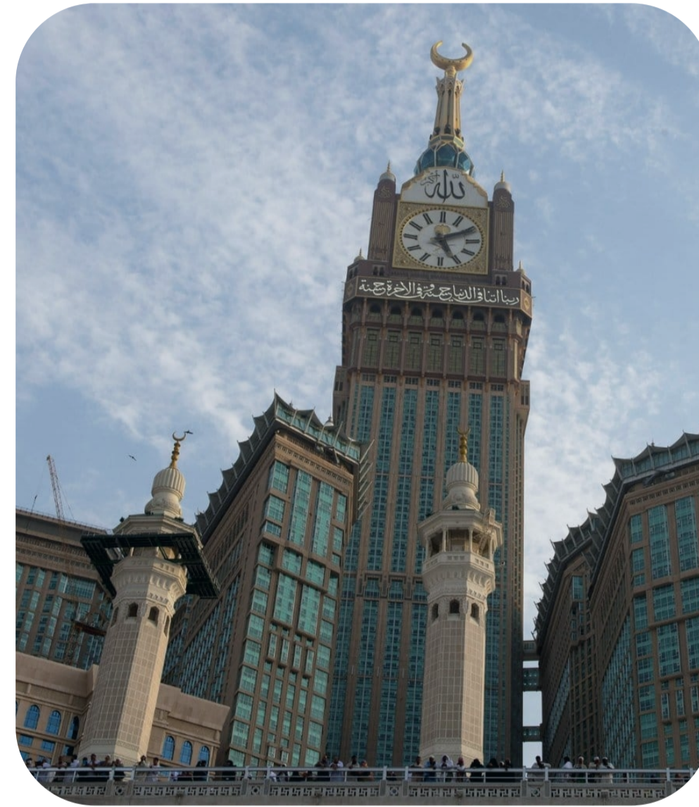
مشروع اعمال التمديدات الصحية في مشروع تطوير وقف الملك (A) البرج عبدالعزیز- مكة المكرمة
