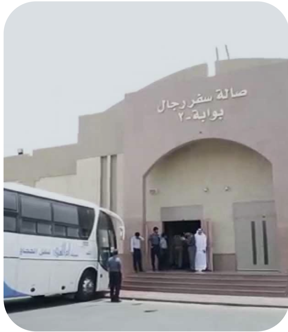
مشروع مركز الايواء (السجون) - الشميسي
