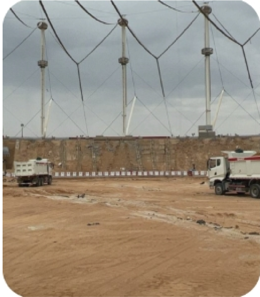
استاد الملك فهد في الرياض أعمال حفر و ردم
